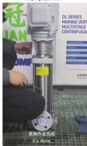
更换作业完成 It's done
