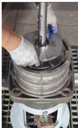
安装叶轮 Installation impeller.
