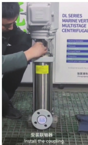
安装联轴器 Install the coupling.
