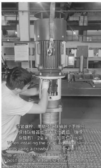
微紧螺栓，用撬棒使联轴器上下移位，保持联轴器处于中间位置后，确保泵轴有1-2毫米自由轴向位移间隙。
