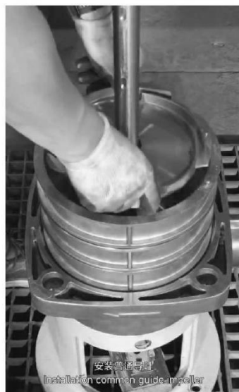
安装普通导叶 Installation common guide impeller.
